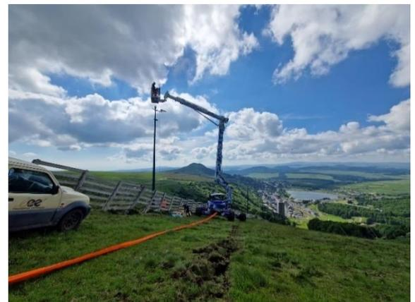
**Le remplacement des projecteurs, par une technologie LED** ainsi que l'intervention sur les armoires en place a débuté pour la phase 1. Il s'agit des pistes « CHIBRET » et « HERMINES », pour les plus aguerris. **Au total une cinquantaine de projecteurs AAA-LUX WS STAD de 1 550 W chacun seront opérationnels au début de la saison prochaine.**
