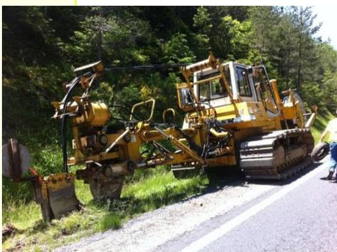
Pose mécanisée du câble avec le SOC de Ceaelec Le Puv Infras
